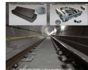
Combinazione della galleria del Gottardo con un'immagine sovrapposta di una traversina montata con gomma e una con gli inserti gomma/metallo
