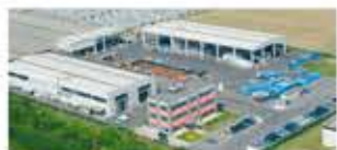
Impianto di Brescello
